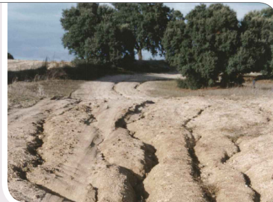
Erosión del suelo en olivar. © FGN
